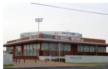
柳島スポーツ公園クラブハウス
