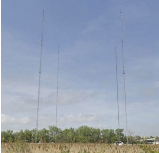
写真 3 WINS の送信アンテナ (指向性)
