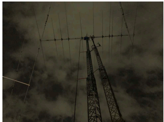
屋上には巨大なアンテナ群
